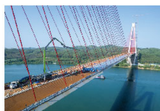
建设项目 武宣黔江特大桥钢箱梁白天STC桥面铺装现场 崇爱高速宁明南互通 崇爱高速长江大桥
